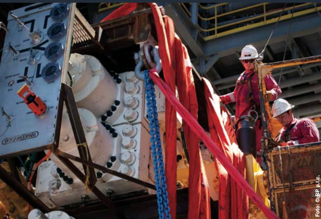
Trabajadores ajustan una válvula para modular la presión de los fluidos que emanan del pozo de Macondo, 8 de julio, 2010.
