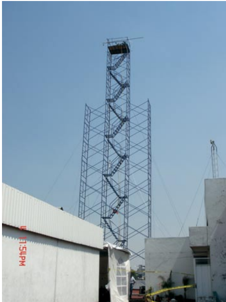
Torre Flux vista desde el edificio de la Red Automática de Monitoreo Atmosférico.
